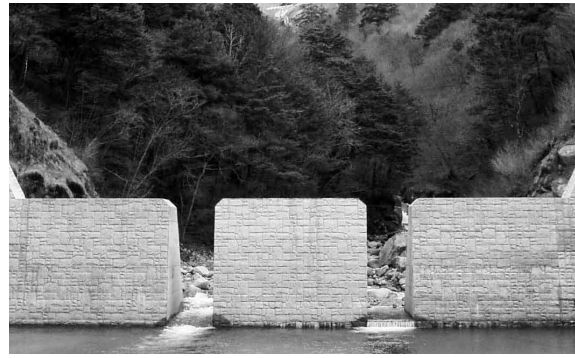
図3. 砂防堰堤のスリット化（山梨県富士川水系）。
